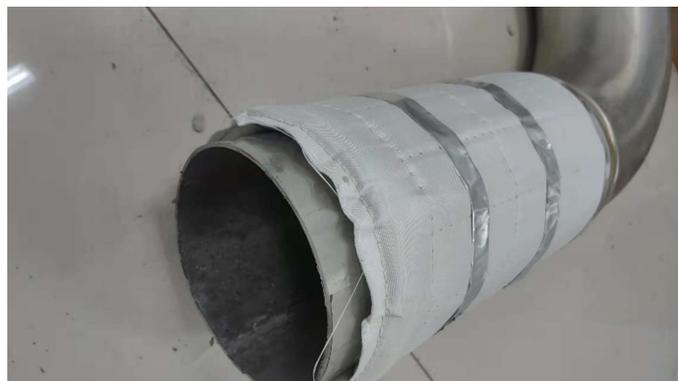
4) 用玻璃丝布通过螺旋缠绕法将材料固定在管道上，缠绕方向应与材料搭接方向一致，捆扎平整，玻璃丝布搭接尺寸为宽度的1/2。推荐使用宽度为10~30cm的玻璃丝布。
